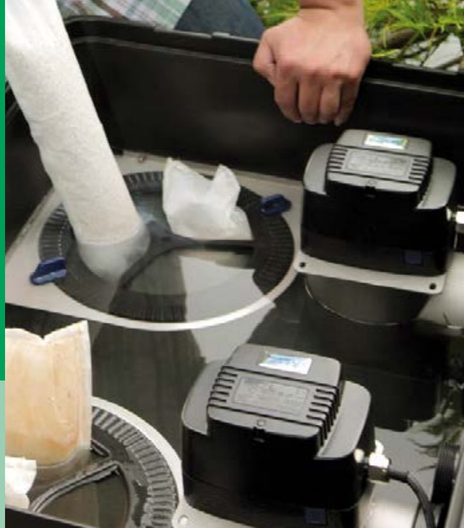
Установка Bitron Gravity в индивидуальном модуле системы фильтрации ProfiClear Premium
